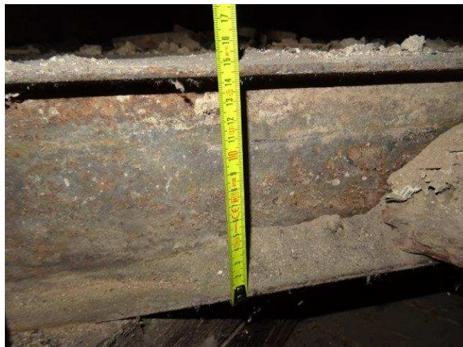
foto /60/ Sonda S24 – konzola s ocelového válcovaného profilu, výška profilu cca 148 mm
