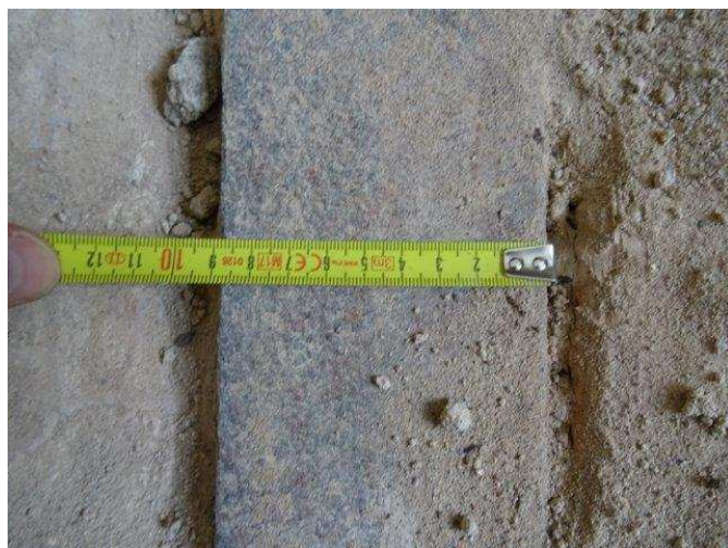
foto /22/ Sonda S6 - naměřená šířka horní pásnice 90 mm
