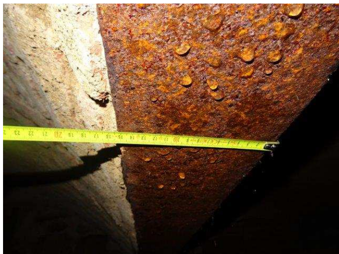
foto /3/ Naměřená šířka profilu P1 - 148 mm
