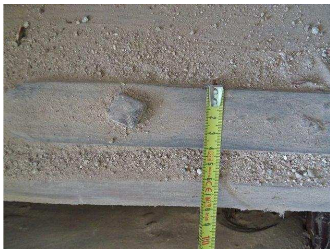
foto /36/ Sonda S13 – ukotvení trámu pomocí kleští
