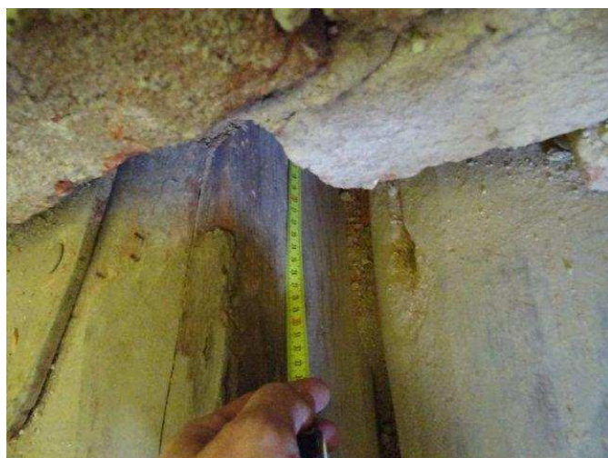
foto /46/ Sonda S18 – uložení trámu cca 220 mm
