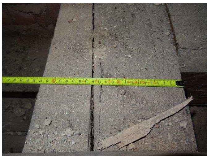
foto /51/ Sonda S21 – šířka trámu 220 mm
