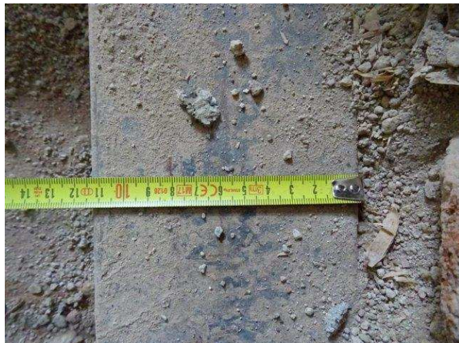
foto /28/ Sonda S10 - naměřená šířka horní pásnice 115 mm
