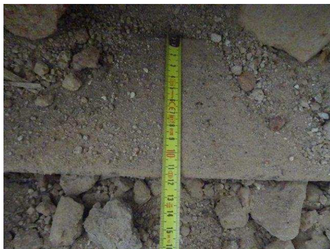
foto /24/ Sonda S7 - naměřená šířka horní pásnice 115 mm
