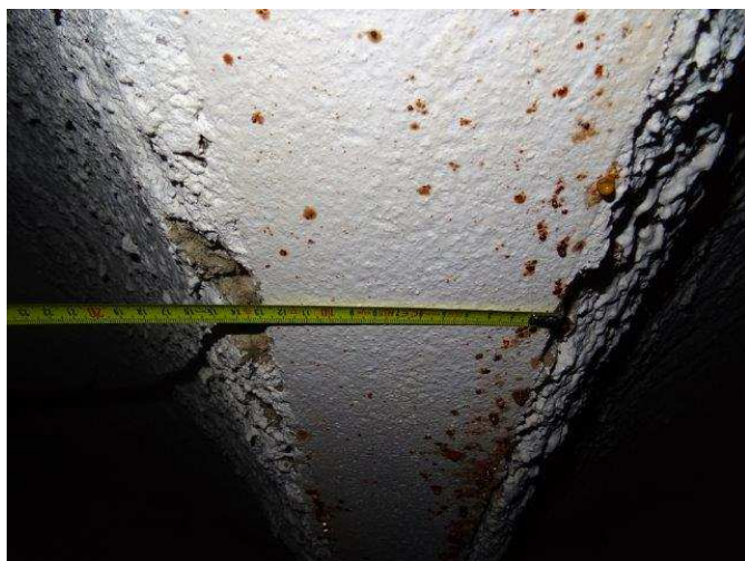
foto /5/ Naměřená šířka profilu P2 - 132 mm
