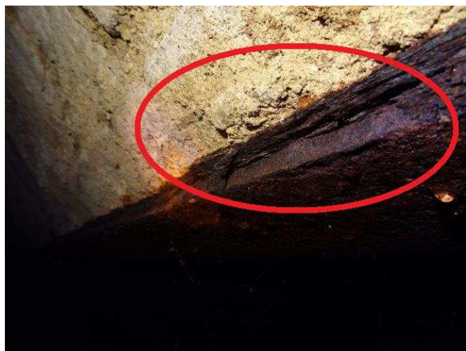
foto /2/ Pokročilá koroze – profil P1
