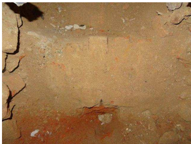
foto /14/ Pata klenby v sondě S1
