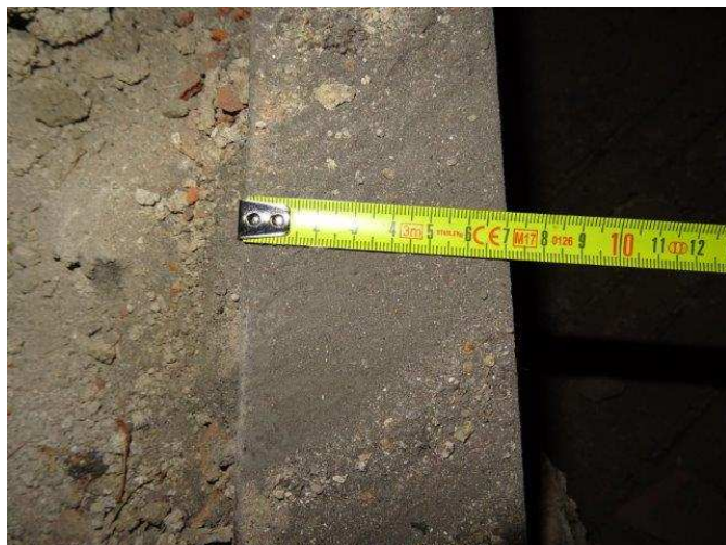
foto /59/ Sonda S24 – konzola s ocelového válcovaného profilu, šířka horní pásnice 72 mm
