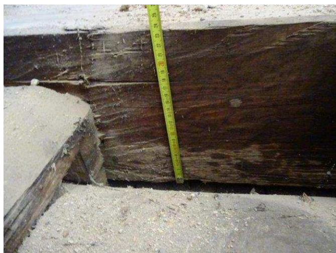
foto /38/ Sonda S14 – výška nosného trámu
