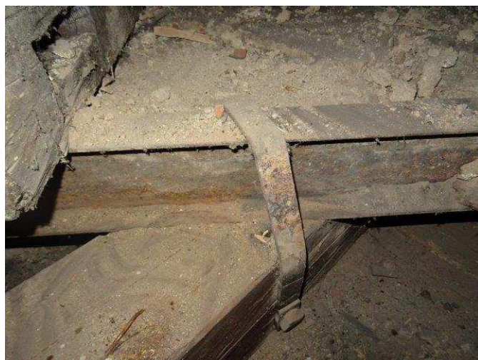
foto /58/ Sonda S24 – detail uchycení konzoly arkýře, ocelový pásek 7 / 40 mm
