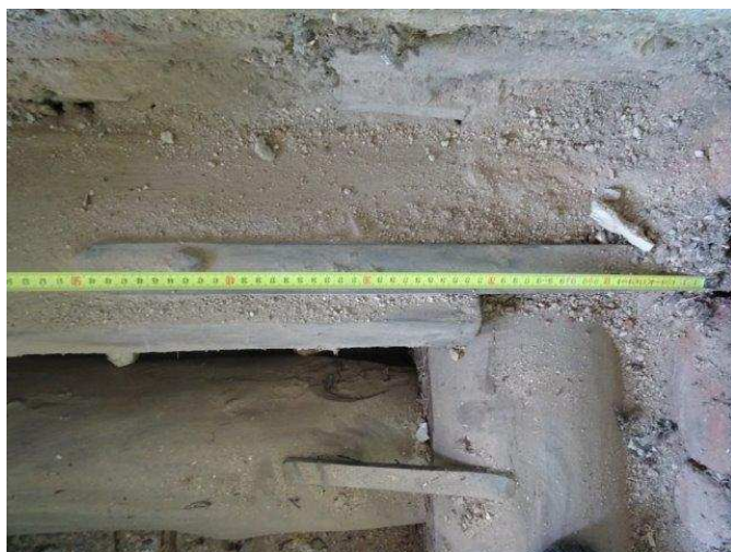
foto /35/ Sonda S13 – ukotvení trámu pomocí kleští
