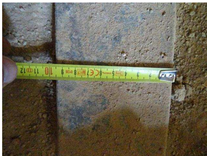
foto /16/ Sonda S3 - naměřená šířka horní pásnice 95 mm
