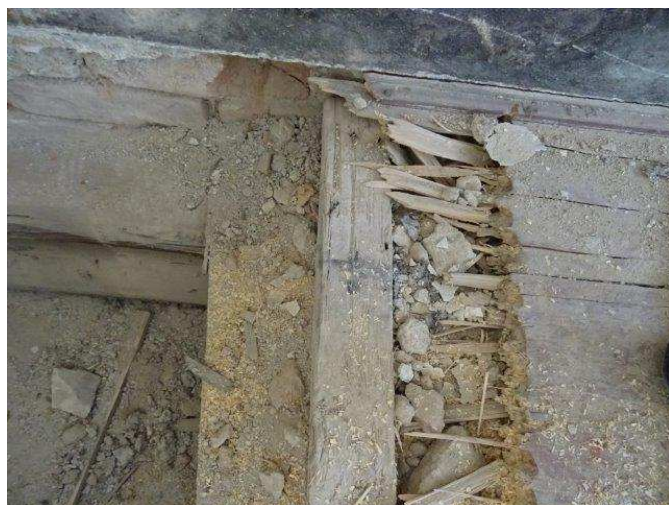
foto /40/ Sonda S15 – hrubá podlaha na polštářích a násypu
