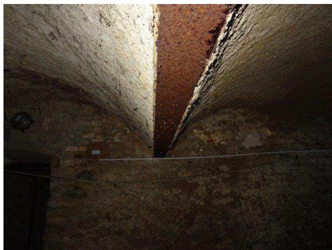
foto /6/ Ocelový profil P3, pokročilá koroze
