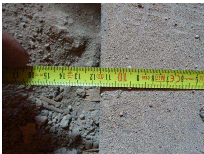
foto /18/ Sonda S4 - naměřená šířka horní pásnice 115 mm
